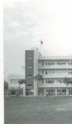
1983年 本館、体育館
