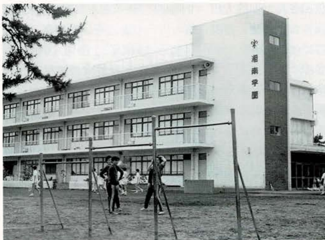
1964年(昭和39年) 小学校鉄筋コンクリート造校舎竣工
