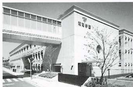
2004年(平成16年) 中高新校舎(2003年竣工)
