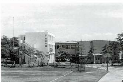
1963年(昭和38年) 62年竣工のRC造校舎
